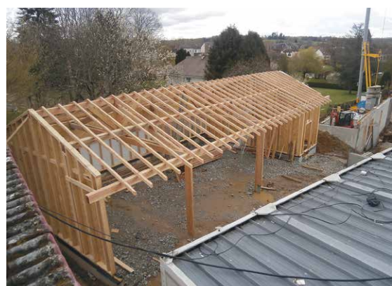
Construction du préau.
