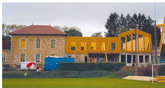
Montage des murs bois.
