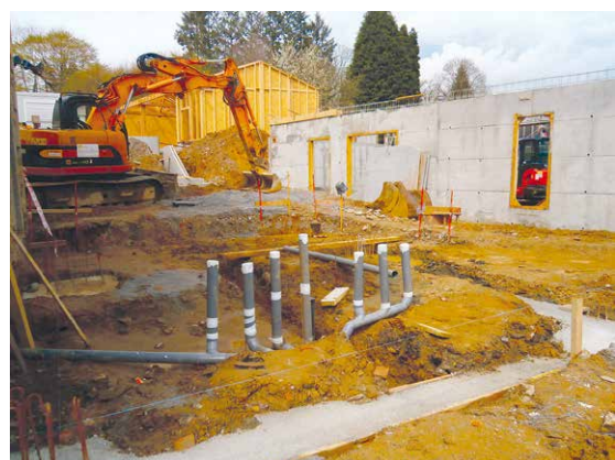
Construction de la salle de motricité.
