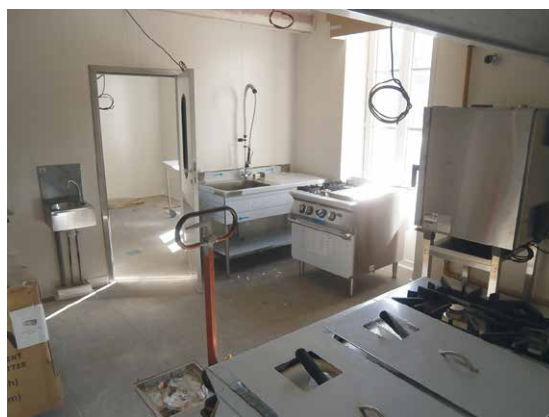
Aménagement de la cuisine.
